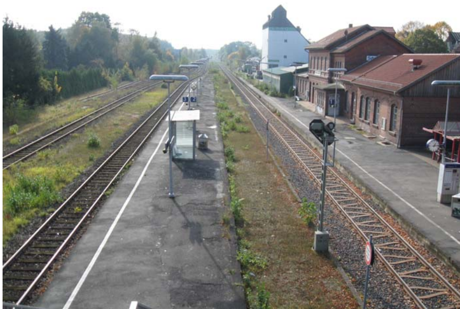
Bf Schwarmstedt vor dem Umbau
