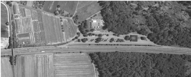
Bild 1: Draufsicht auf die bestehende Anlage
