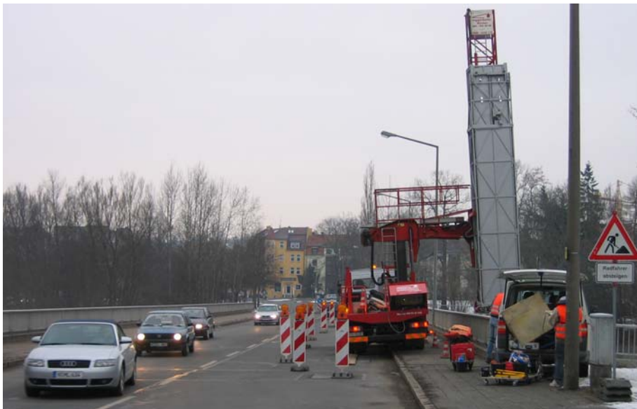
Verkehrssicherung während der Prüfung
