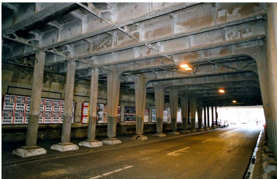
Ansicht Rahmenkonstruktion und Pendelstützen
