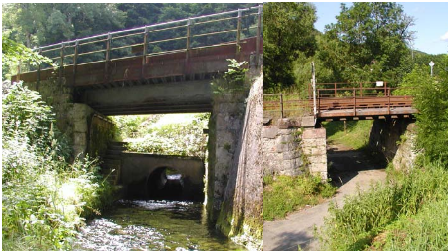
Bild 1: bestehende EÜ bei Bahn-km 19+944
