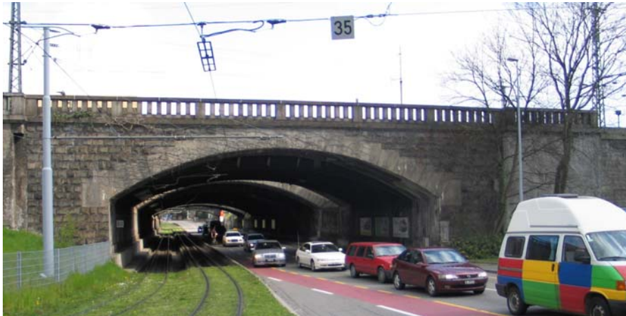
Bild 1: Ansicht Westportal Riehenstraße
