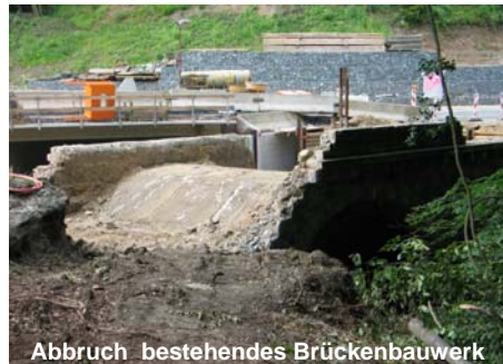
Abbruch bestehendes Brückenbauwerk
