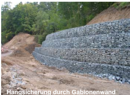
Hangsicherung durch Gabionenwand
