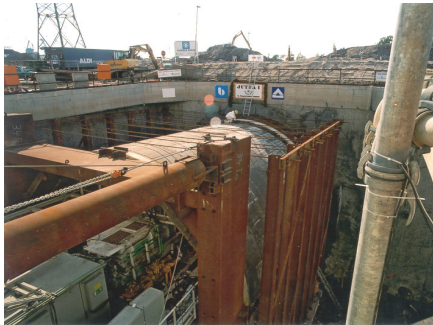
Südröhre mit fertig montierter TBM
