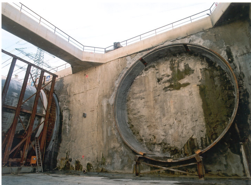
Blick auf die Anfahrwand der Nordröhre
