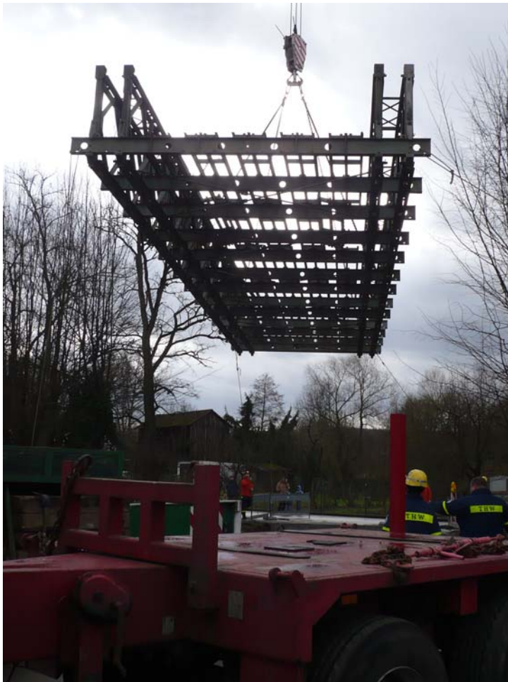
Bild 3: Einbau der Hilfsbrücke / Bailey Brücke
