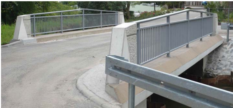
Bild 1: Neue Mühlwegbrücke über den Mühlkanal in Zuzenhausen
