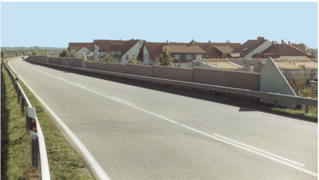
Schallschutzwand entlang des Baugebietes „Böhler Straße“
