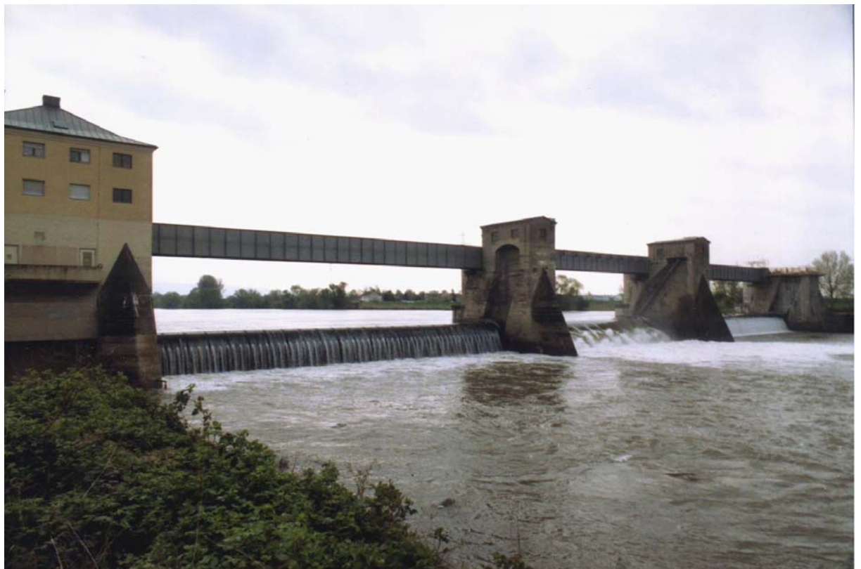
Ansicht im Bauzustand an Pfeiler 1
