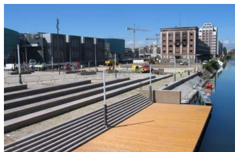
... und nach der Maßnahme
