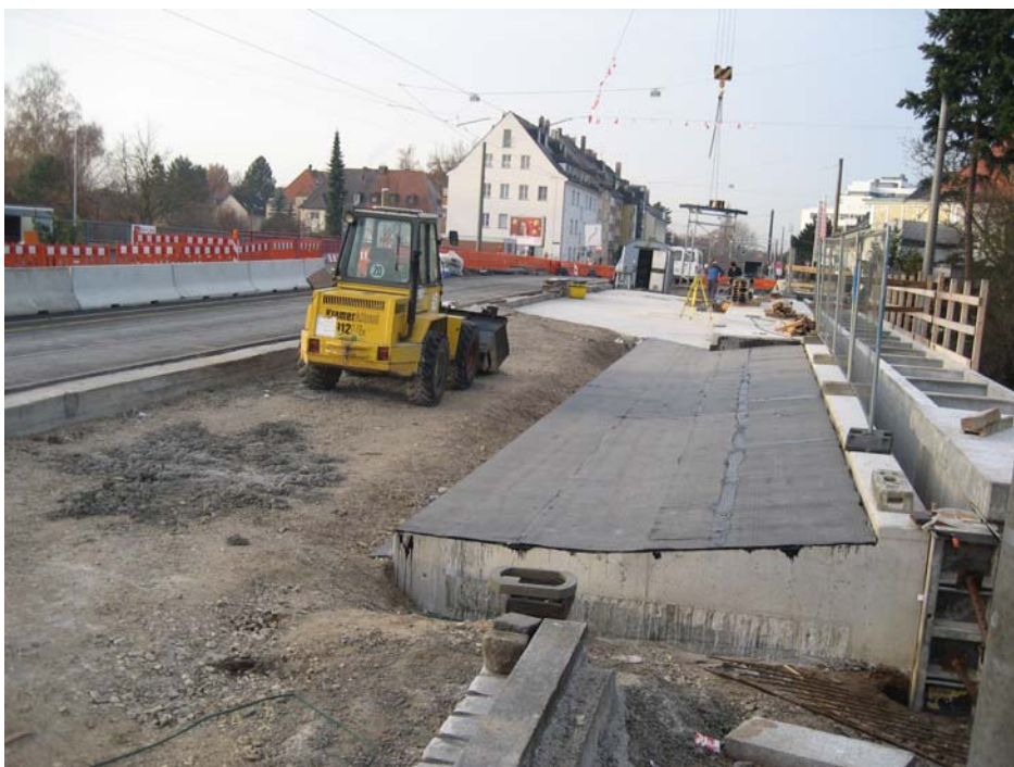
Bauabschnitt 2, Herstellung des nördl. Überbauteils; Straßenverkehr läuft über neu errichtete SBR
