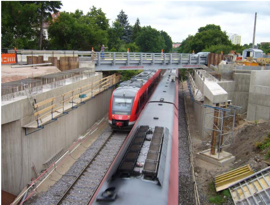
Bauabschnitt 1, Herstellung des südl. Überbauteils und nördl. liegende Straßenhilfsbrücke
