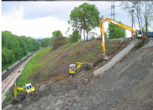
oben links: Bauphase; Herstellung der Gabionenwand unten links: Bauphase; Herstellung Sickerpackungen
