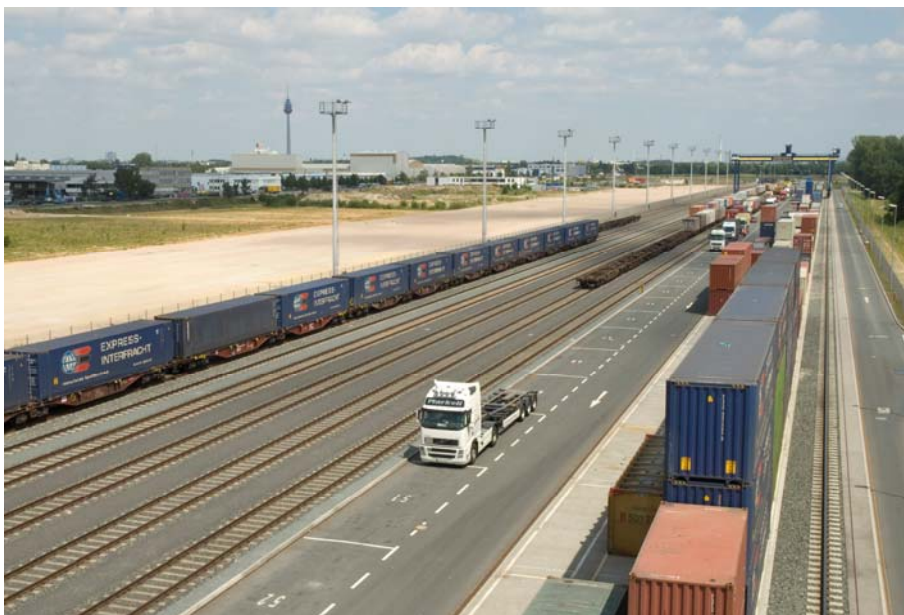
Im Vordergrund: Modul 1 der Hafen Nürnberg – Roth GmbH Im Hintergrund: Bauvorbereitenden Maßnahmen des Moduls 2 der DB Netz AG
