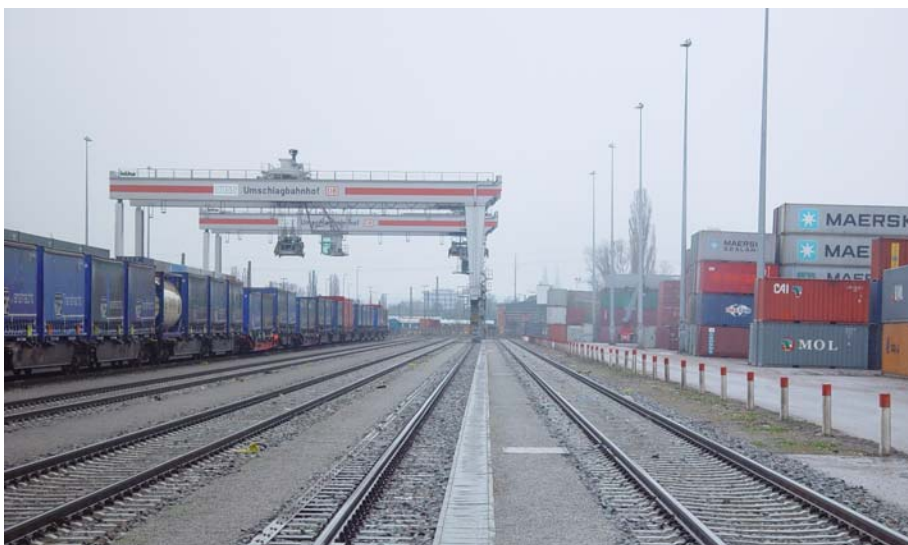
Blick auf Umschlagkran und Abstellgleis 1
