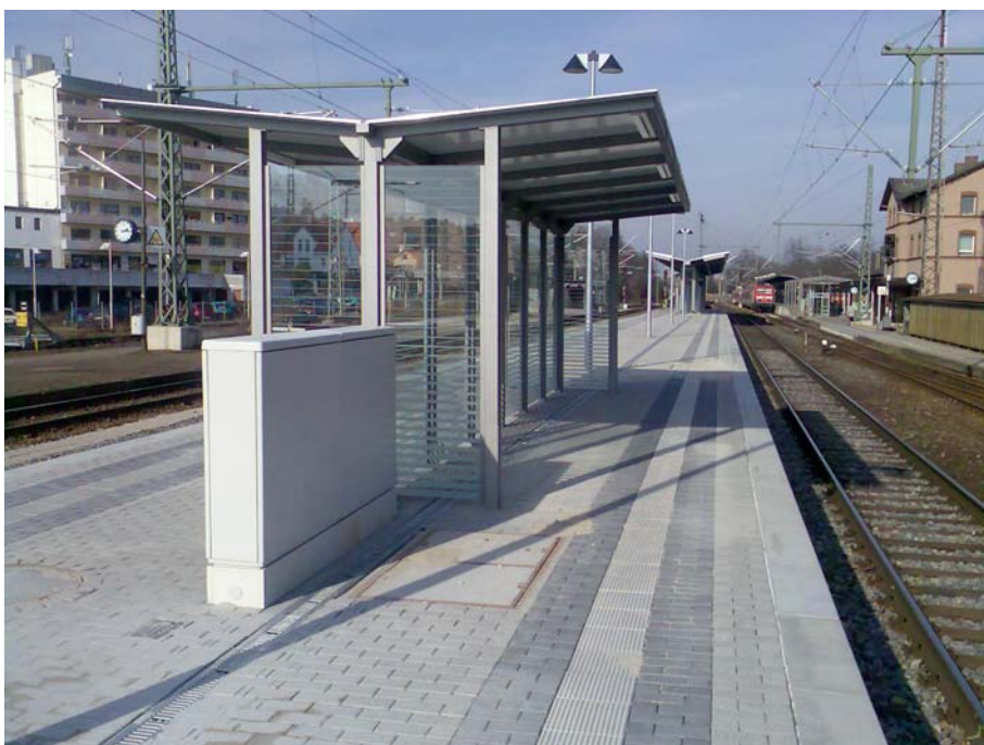
Blickrichtung Empfangsgebäude Bf Roth
