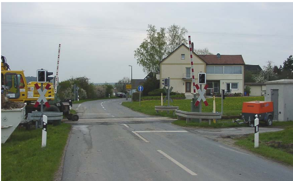
Technisch gesicherter Bahnübergang mit Lichtzeichen und Halbschranken Lz(H)-ÜS
